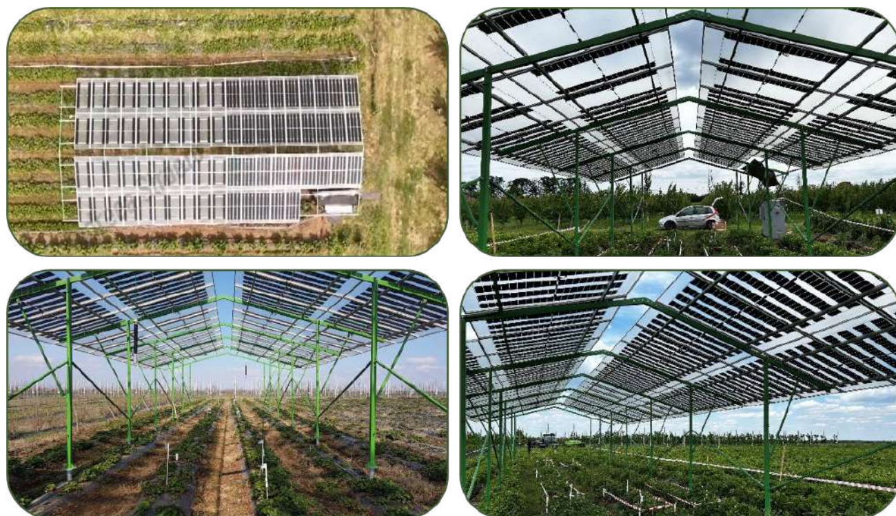
Figura 15.3.2 – Platforma hortivoltaică de la Baza Experimentală Moara Domnească: dispunerea culturii și variantele V1 – transparență de 48,92%, V2 – transparență de 77,01% și martorul neacoperit (sursa: date proprii ale proiectului)
