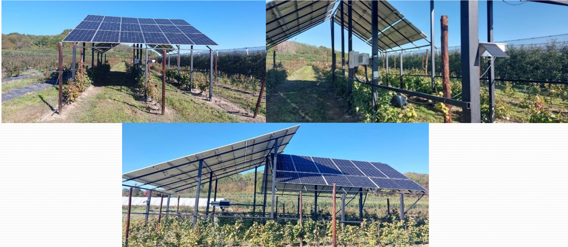
Detaliu dispozitiv experimental-plantație de coacăz roșu acoperită cu panouri fotovoltaice cu expunere unică-sudică și dublă-estică și vestică (ICDP Pitești-Mărăcineni)
